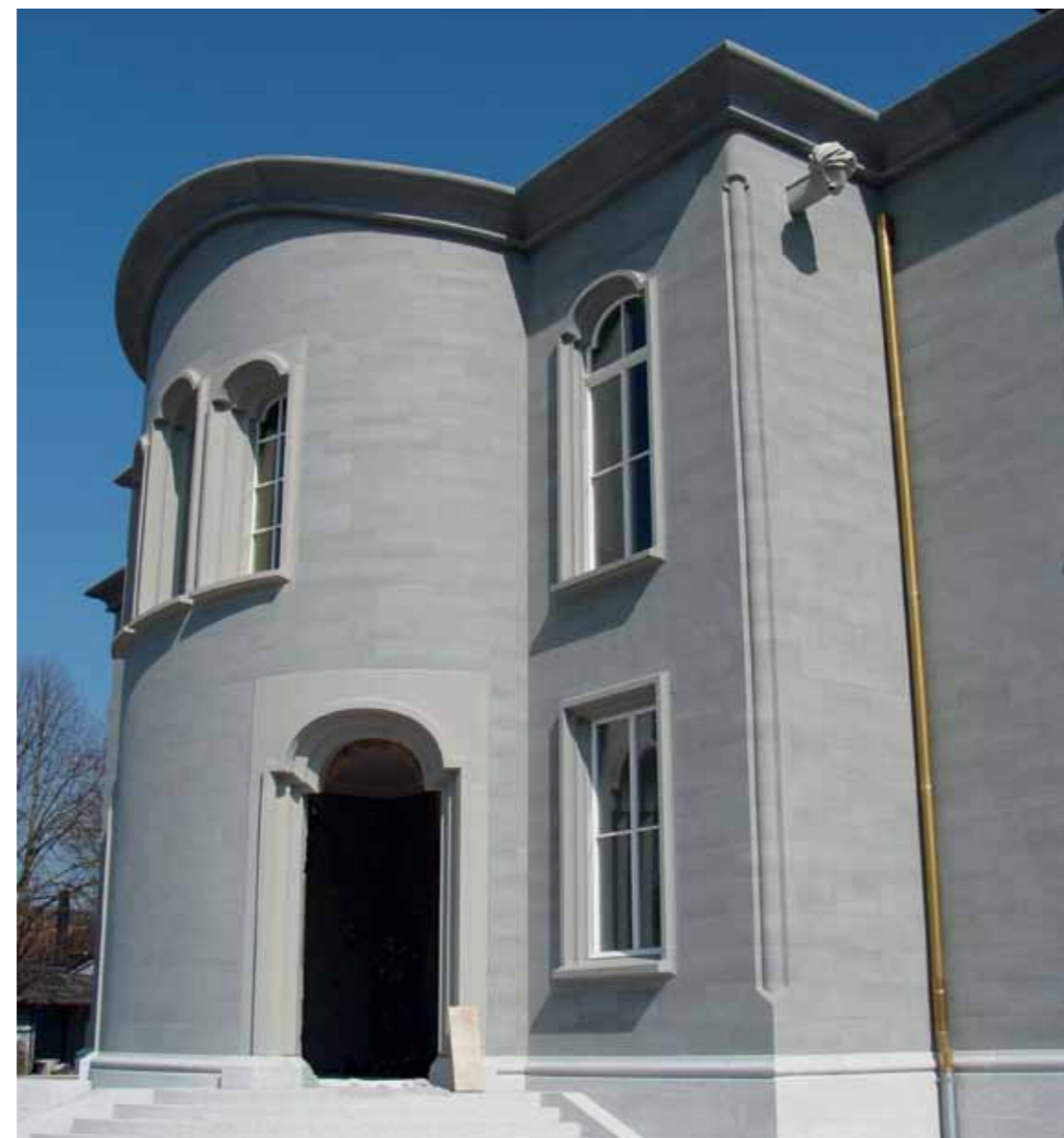
Gebäude mit Massivfassade aus Rorschacher Sandstein
